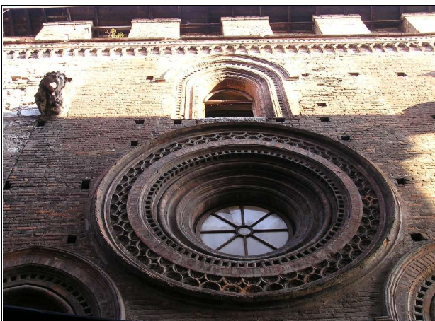
Sant'Agostino. Particolare della facciata, tutta in laterizio, con le decorazioni in cotto del rosone e delle finestre.
